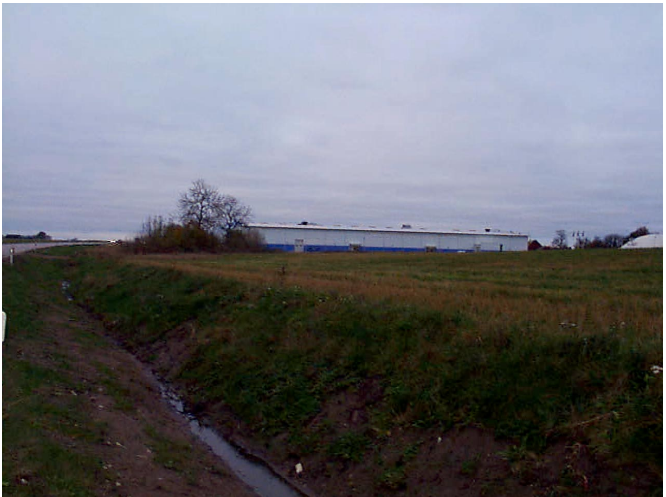
Väg 46, kv. Traversen med norrfasaden på Aristos nyuppförda industribyggnad, "de båda träden", höjdryggen och kv. Trucken med Kupolen (foto från norr)
